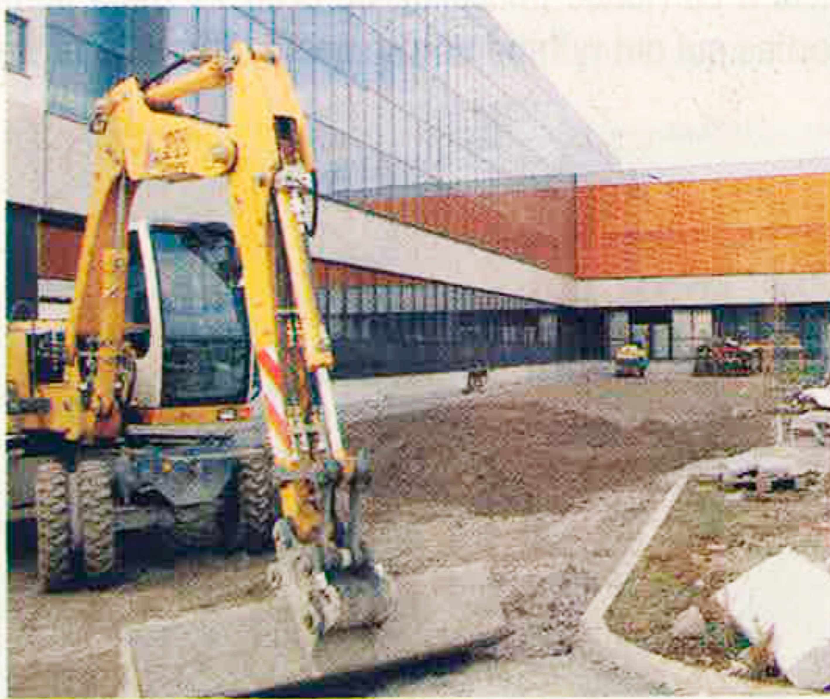
En quatre ans, une quarantaine d'entreprises ont été amenées à travailler sur le chantier. (Photo DNA)
