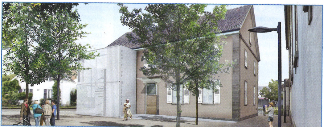
Au 25 rue des Voyageurs, la nouvelle cage d'escalier sera intégrée dans une structure métallique
